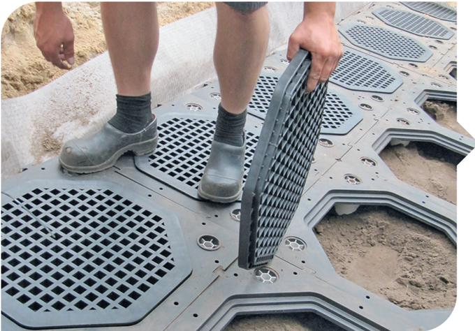
بعد التركيب يتم ختم النظام وإغلاقه. يجدر بالذكر أنّ النظام الواقع تحت الرصيف يسمح بتسرب مياه الأمطار إلى التربة من خلال فتحات الأغطية المنفذة للماء.
